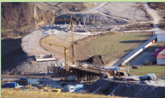
Pohľad na výstavbu obchvatu z polovice novembra.
