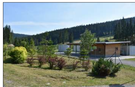
Čistiareň odpadových vôd v Oraviciach.
