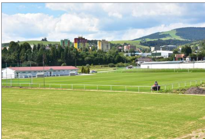
Výstavba nového futbalového ihriska.
