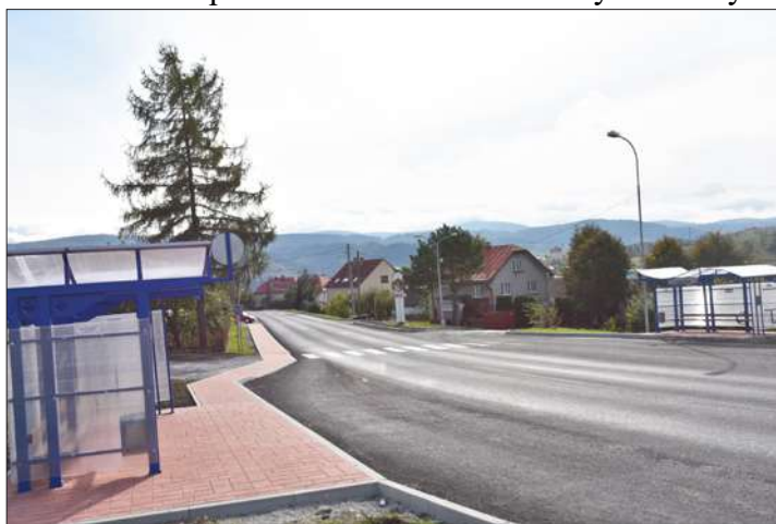
Ulica Školská - výstavba nového chodníka.
