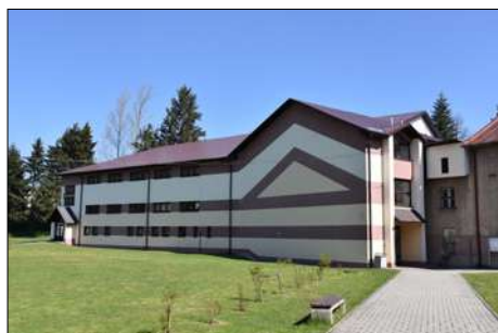
Nová strecha na športovej hale.
