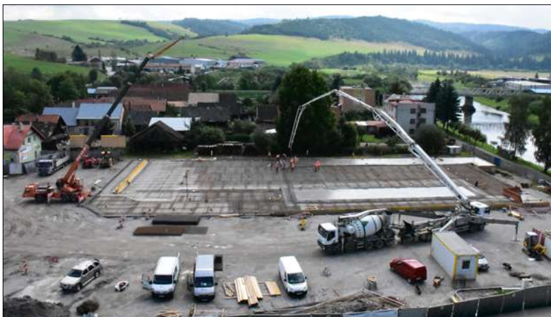
Pohľad na stavenisko - výstavba OD Lidl.
