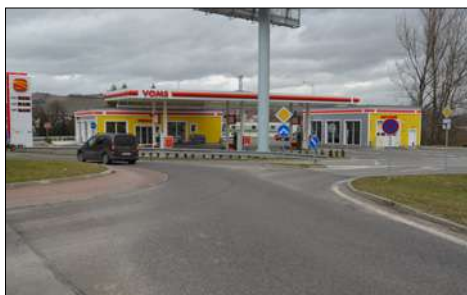
Otvorenie benzínovej stanice VOMS.
