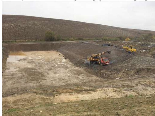
Výstavba novej kazety komunálneho odpadu.
