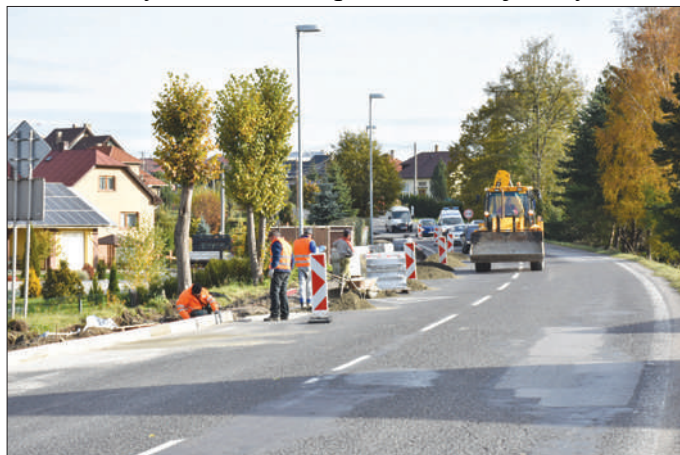
Ulica Nová - výstavba nového chodníka.
