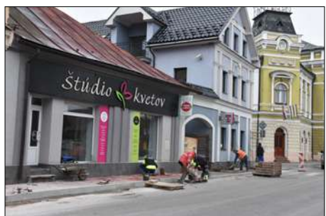
Pokládka nového chodníka.
