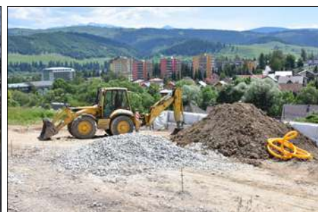
Výstavba kanalizácie na IBV Varta.
