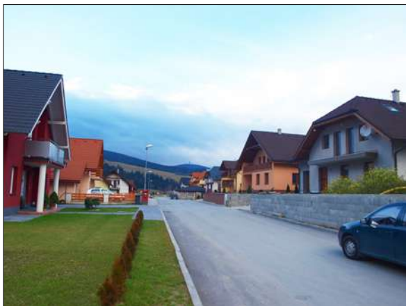
IBV Pod Žiarcom - výstavba cesty.
