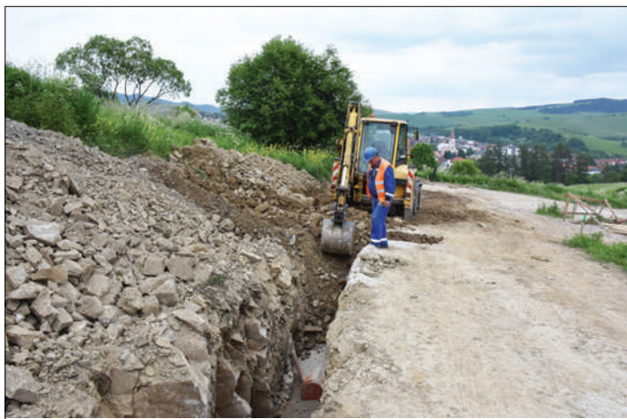
IBV Varta - výkopové práce - kanalizácia.
