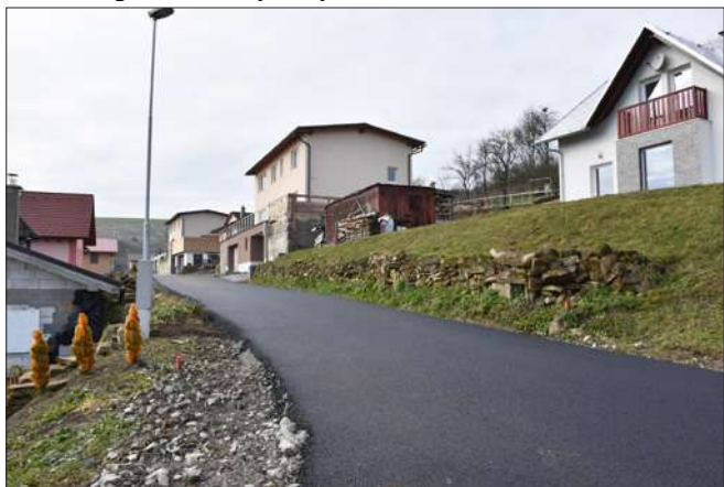
IBV Široky - výstavba cesty.
