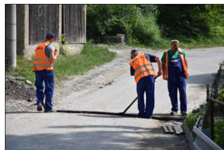
Práce na ceste do Štefanova.
