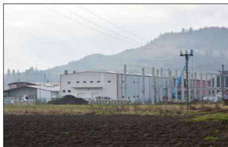
Výstavba novej haly firmy Hydac.
