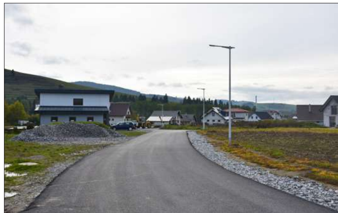
IBV Breziny - výstavba cesty.
