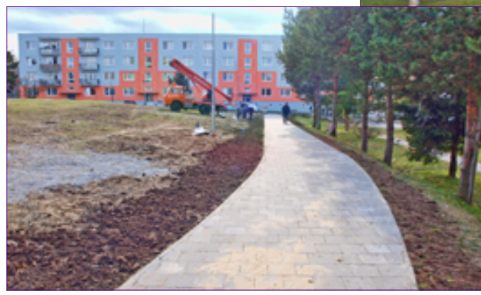
Nový chodník, verejné osvetlenie a rozšírenie parkoviska pri bytovke č. 19.
