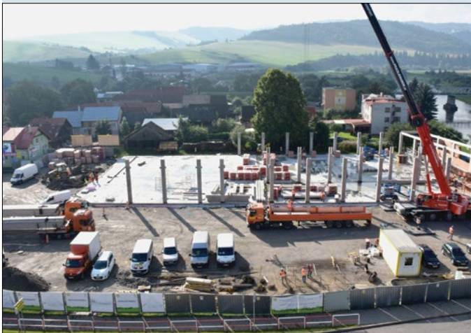
Pohľad na stavenisko z hotela Limba.
