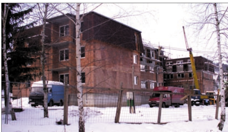
Na novej bytovke neustal pracovný ruch ani v zimných mesiacoch a čo nevidieť sa do nej budú sťahovať noví nájomníci.
