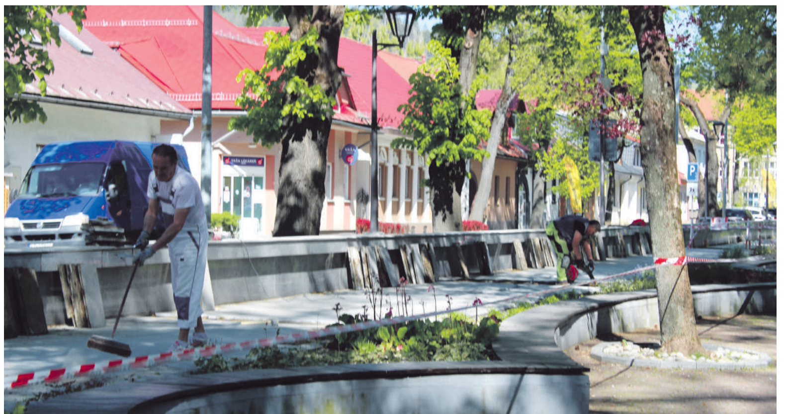
Oprava dlažby na Trojičnom námestí.
